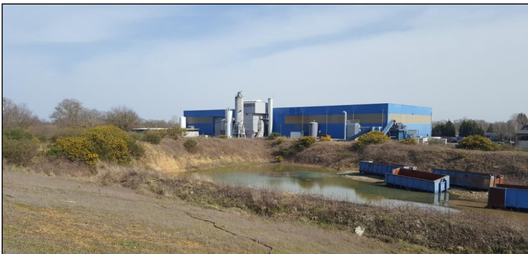
Bâtiment n°3 côté Ouest
